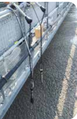
Abb. 1: Installierte FDO®-Sensoren mit und ohne Druckluftreinigung
