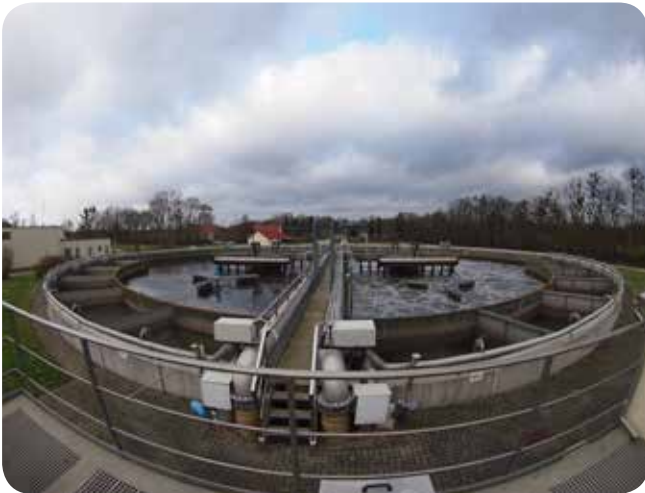
Abb. 1: Zwei der vier identisch aufgebauten SBR-Becken.
